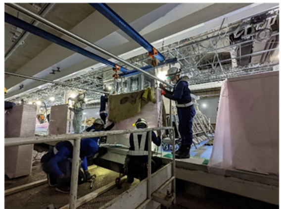
⑥地下駅舎部：プラットフォームの進捗状況 （ホームドア工事）
